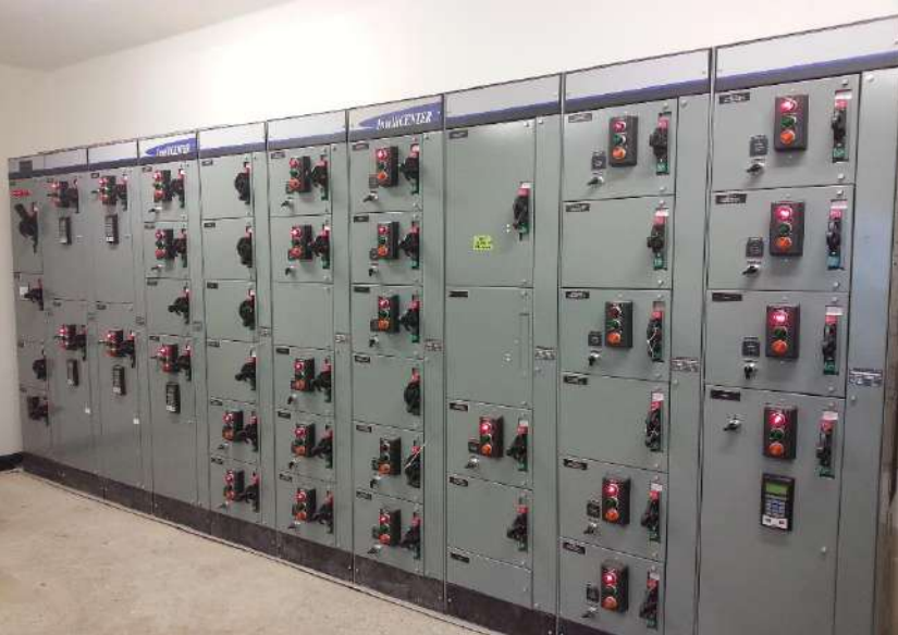
Proyecto: Automatización Planta de Tratamiento de Aguas Servidas ESSAL Chaitén Imaspa S.P.A., Septiembre 2014
